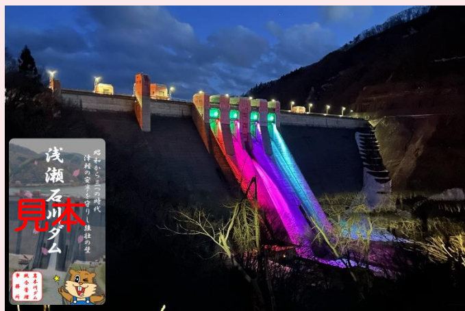
▲浅瀬石川ダムライトアップ状況とダム印シール
