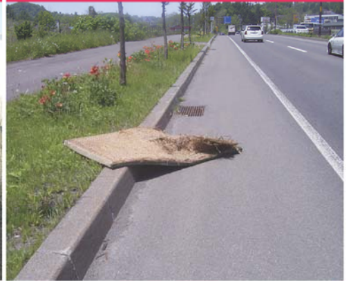
路面の落下物
