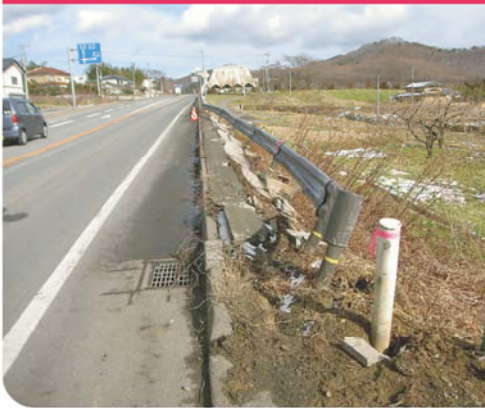
ガードレール・標識等の損傷
