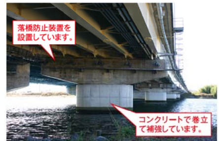
▲鮫川大橋の耐震補強状況
