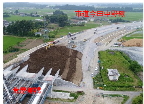
⑥ 相馬山上IC(路床盛土施工中)
