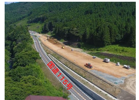
⑥ 相馬山上IC(路床盛土施工中)
