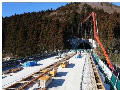
④ 横川高架橋(床版完成)
