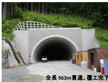
⑤ 円淵トンネル(福島側坑口)
