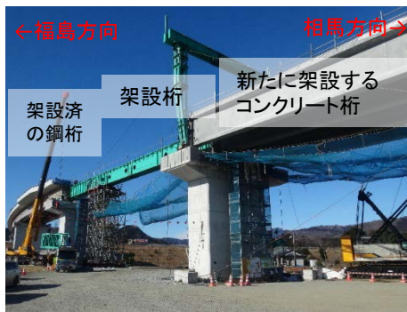
② 今田高架橋(相馬側架設中)
