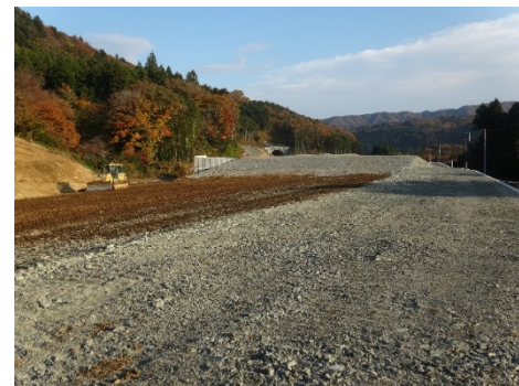
⑥ 相馬山上IC(東側盛土施工中)
