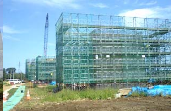
今田高架橋(東側)
