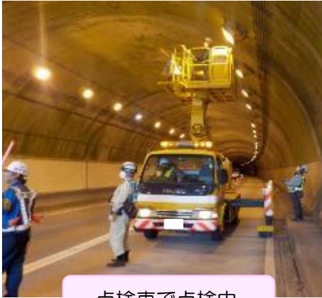
点検車で点検中
