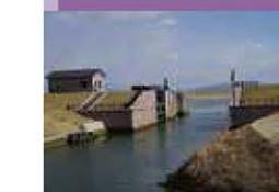
野蒜水門は、高潮や洪水時の浸水被害を防ぐために平成15年に設置され、平成23年3月11日東日本大震災によって被災を受けました。大きな損壊はありませんでしたが、現在の野蒜水門は、堤防の嵩上げに合わせて改築した新しい水門です。
