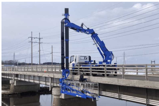
◀ 橋梁点検イメージ
