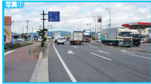
▲ 4車線区間の状況 (桑折町上郡 H22.6)
