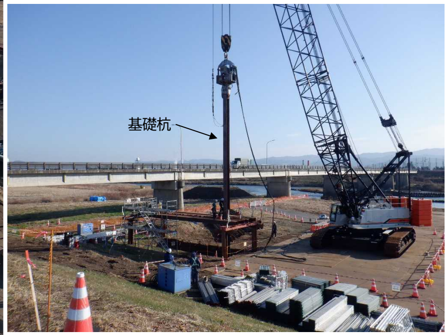
③仮橋の基礎杭打ち込み状況
