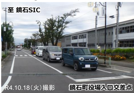
②町道(駅中央線・下り)
