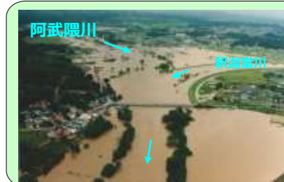
平成10年8月洪水被害状況 【福島県須賀川市】
