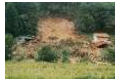
土砂崩れにより住宅全壊(白河市(旧大徳村))
