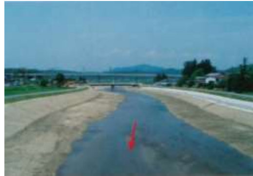
平成12年5月工事完了
