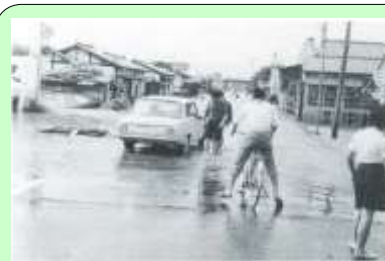
昭和41年9月洪水被害状況 【福島県福島市】
