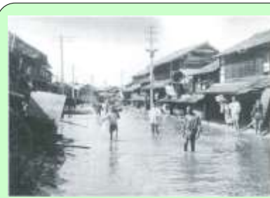
大正2年8月洪水被害状況 【福島県旧本宮町】
