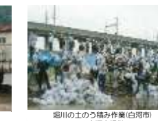
堀川の土のう積み作業(白河市) ※白河市提供
