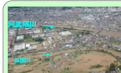
平成23年9月洪水被害状況 【福島県郡山市】
