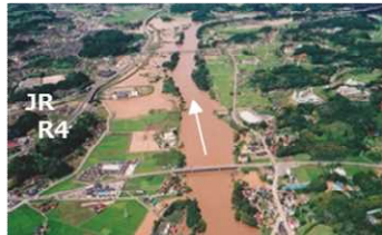
国道4号が浸水、JRに影響した二本松市内
