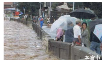
平成14年7月洪水の被害状況
