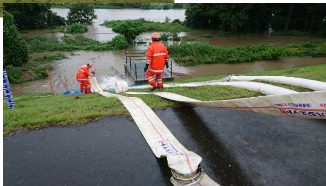
排水作業の事例
