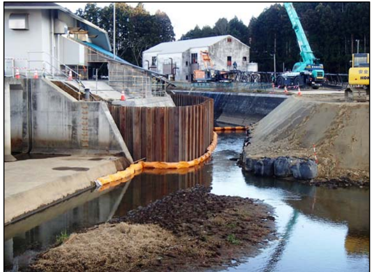
(鋼矢板打込み完了：上流側)
