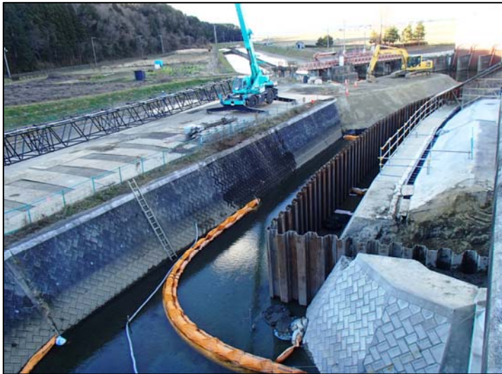
(鋼矢板打込み完了：下流側)
