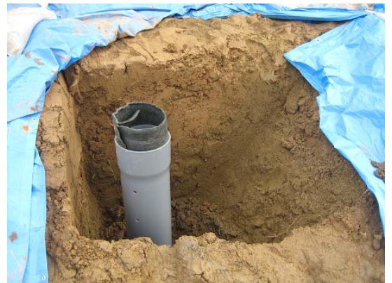
L=4m、口径200mmの管を3本建込
