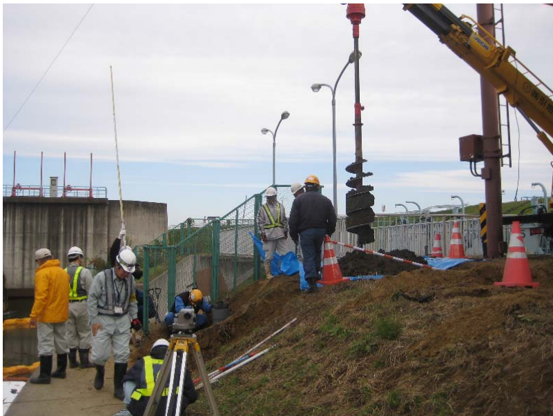
ストレーナー管建込状況
