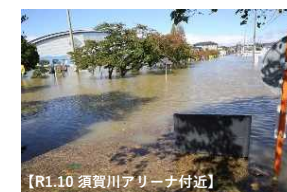
令和元年東日本台風による浸水状況
