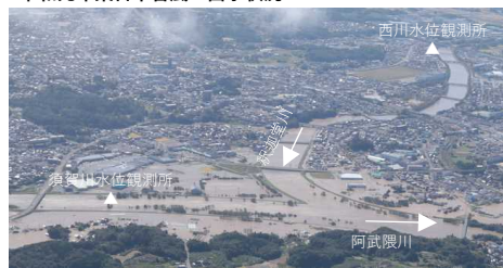
令和元年東日本台風の出水状況
