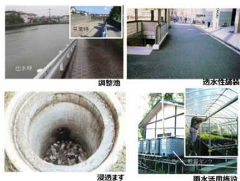
雨水貯留浸透施設の例
