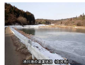
農業用ため池の治水整備
