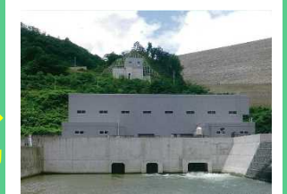
発電所（胆沢第一・第三）
