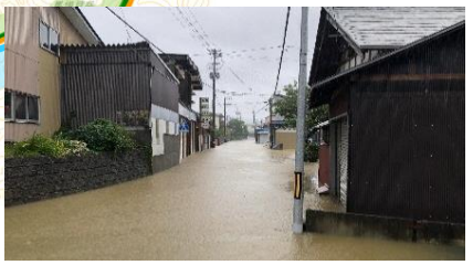
三種川沿川の家屋浸水(下岩川長面地区)
