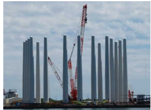
▲タワー組立状況(秋田港湾事務所提供)
