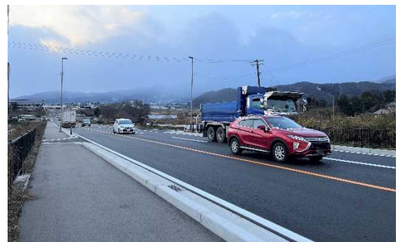
▲一部開通した付加車線の状況(石母田工区)
