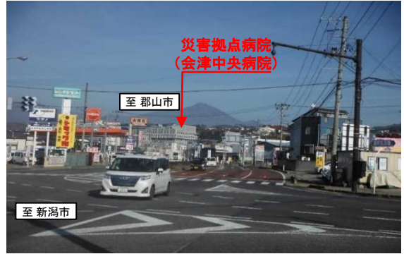
▲ 国道49号の電柱状況
