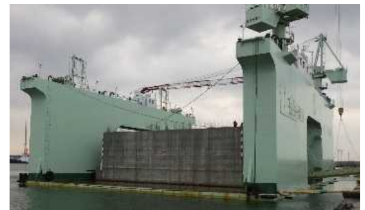
▲ 防波堤として使用する『ケーン(※)』の製作状況 ※ケーン: 防波堤を形成するコンクリートの箱
