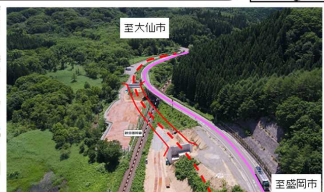
▲急カーブ区間の状況
