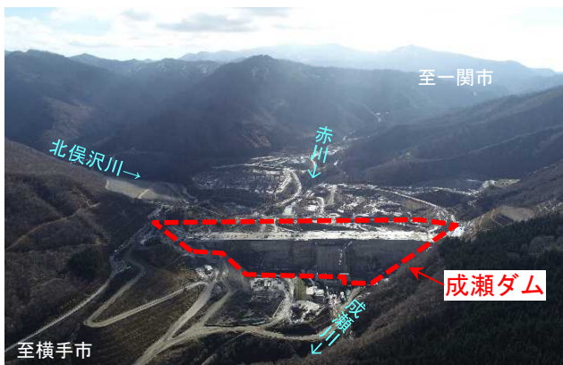
[下流側から望むダムサイト施工状況]
