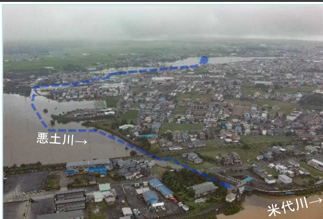
▲令和5年7月出水による被害状況
