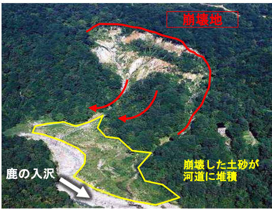
▲角川流域 鹿の入沢で発生した崩壊(H6)
