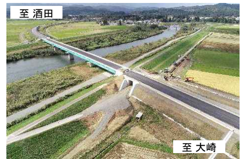
▲国道47号 新庄古口道路の整備状況
