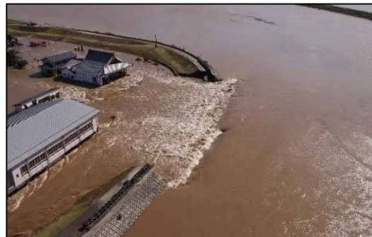
R1洪水による堤防決壊状況
