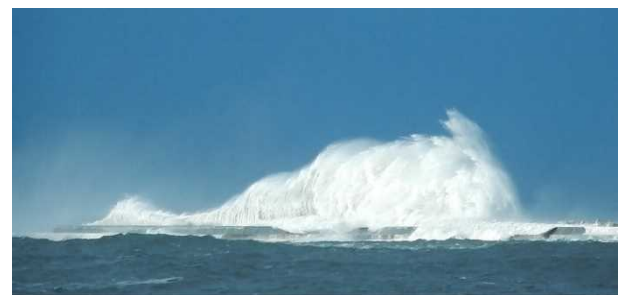
▲荒天時における防波堤(沖)での越波の様子
