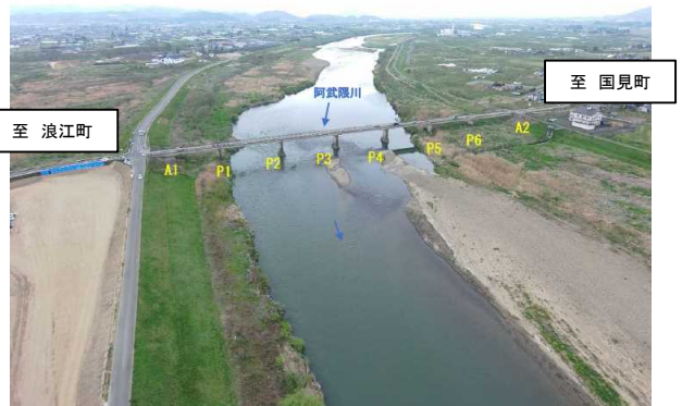
▲伊達崎橋 全景
