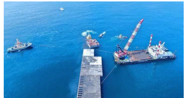
▲防波堤整備の様子(ケーソン※据付)
