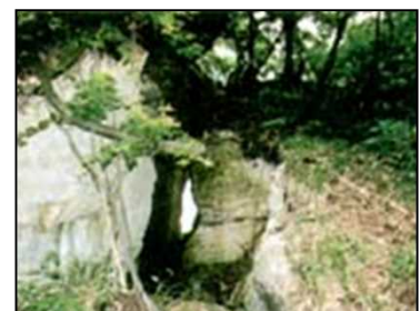
H6年頃 そでのざわ 袖ノ沢地区の地割れ
