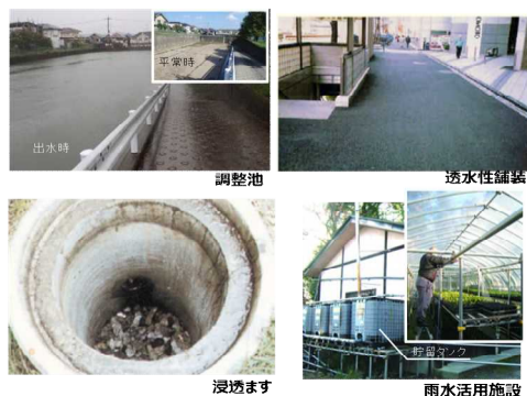
雨水貯留浸透施設の例
