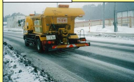
散布車による散布状況
