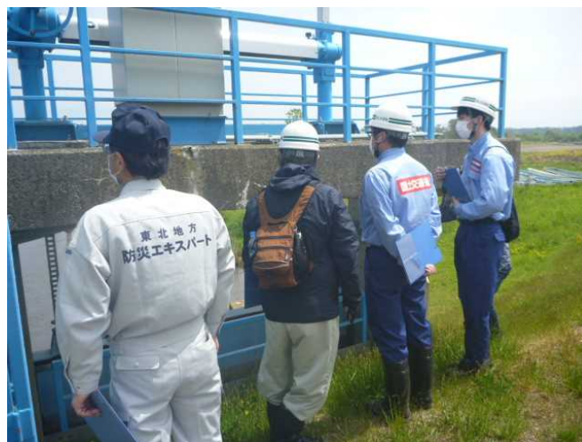
排水樋門の点検状況
