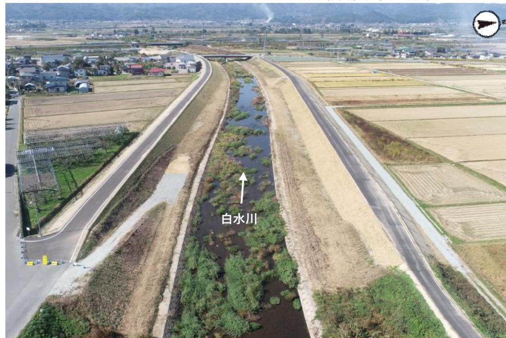
施工状況(R4.10月)
