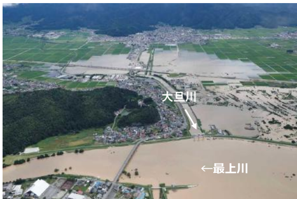
被災状況(R2.7月)
