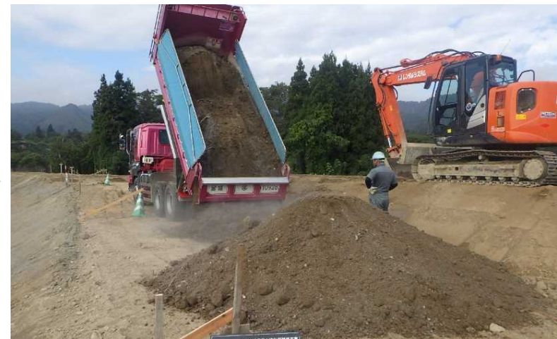
河道掘削工事において掘削した土砂を、長島地区の築堤工事の盛土材として活用
