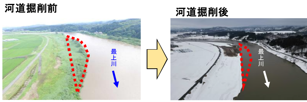
最上川中流血島地区ほか河道掘削工事
