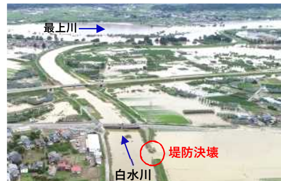
被災状況(R2.7月)
