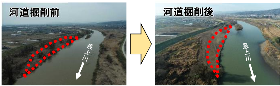
最上川上流吉田地区河道掘削工事
