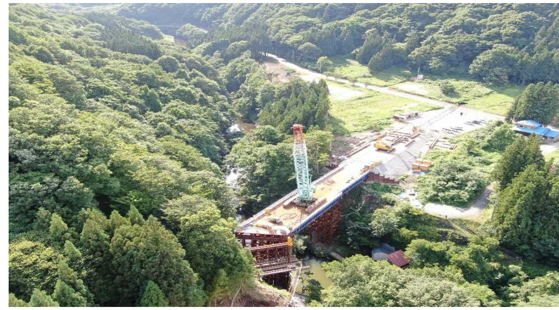
工事現場の見学
