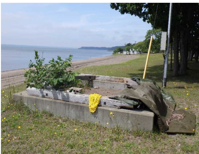
点検状況(三沢湖水浴場)
