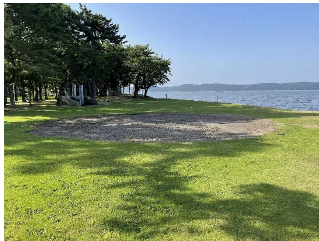
不具合箇所(ベンチの破損) 撤去済み
