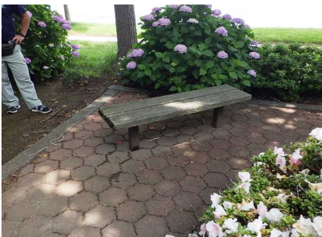
点検状況(小川原湖公園)
