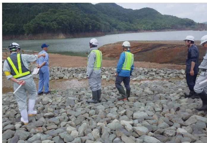
占有者との点検(津軽白神湖パーク)
