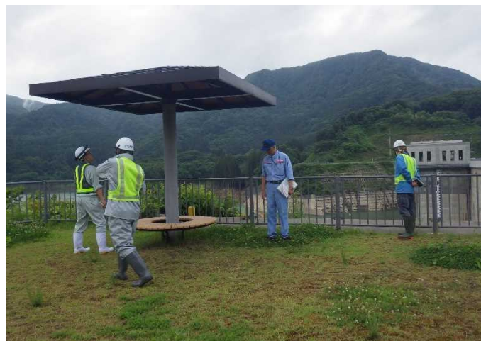
占有者との点検(津軽ダムパーク)
