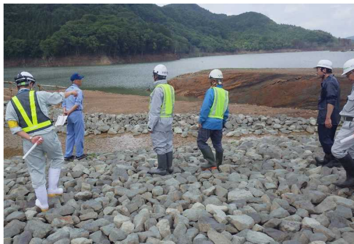
占有者との点検(津軽白神湖パーク)
