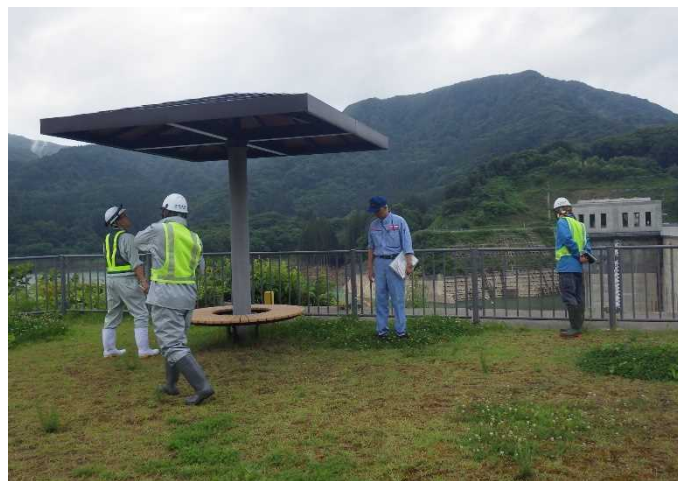
占有者との点検(津軽ダムパーク)
