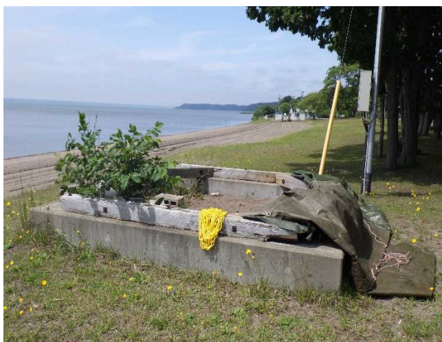
点検状況(三沢湖水浴場)
