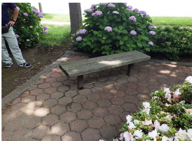
点検状況(小川原湖公園)
