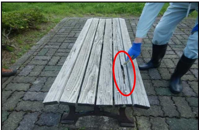
●ベンチの破損
