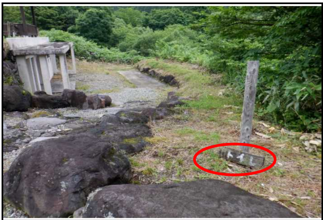
●トイレ看板の落下
