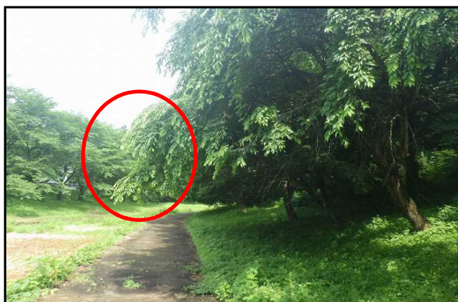
●木の枝の遊歩道上への張り出し
