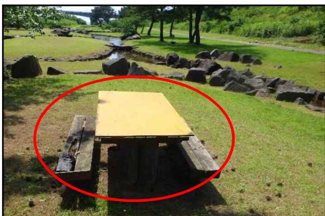
●テーブル・ベンチの腐食
