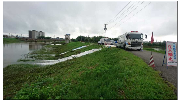
平成29年7月豪雨 福部内川での排水作業
