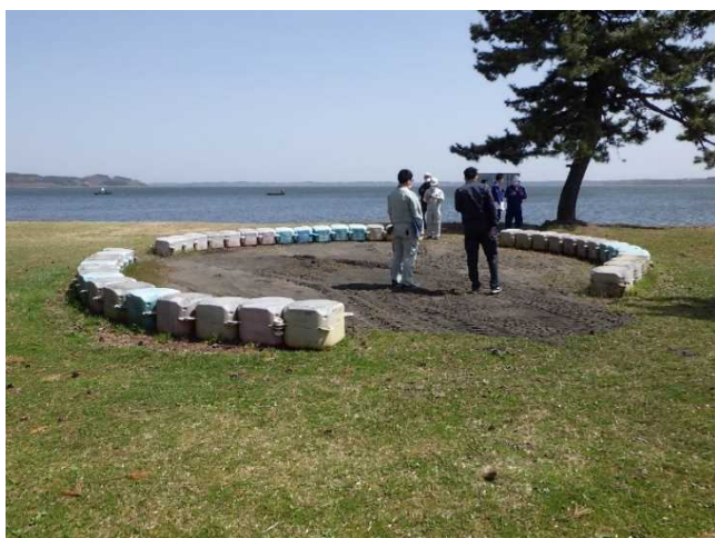
点検状況(小川原湖公園)
