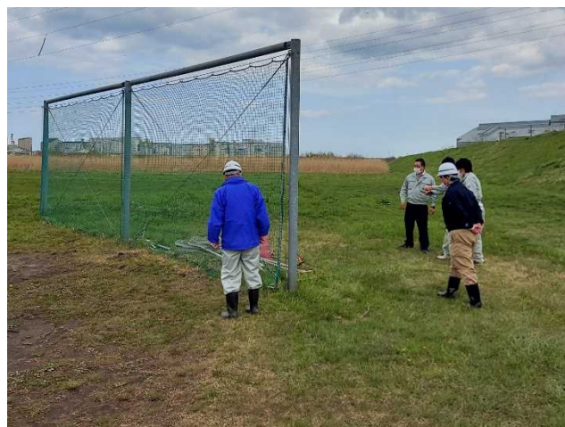
点検状況(馬淵川公園)
