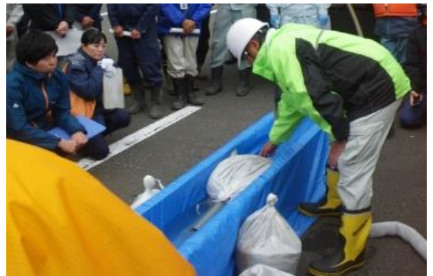
側溝での油回収
