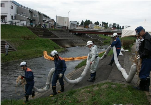
赤川にオイルフェンスを設置
