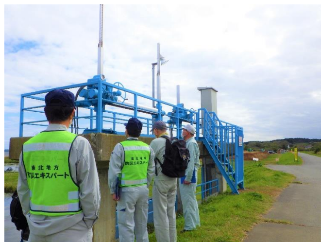
排水樋門の点検状況
