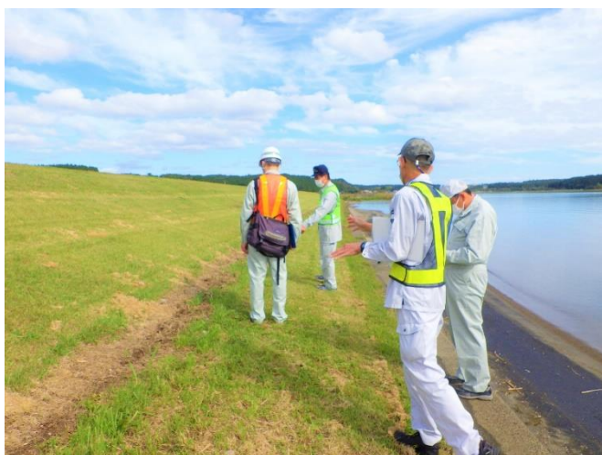
堤防の点検状況
