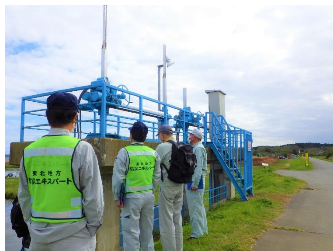
排水樋門の点検状況
