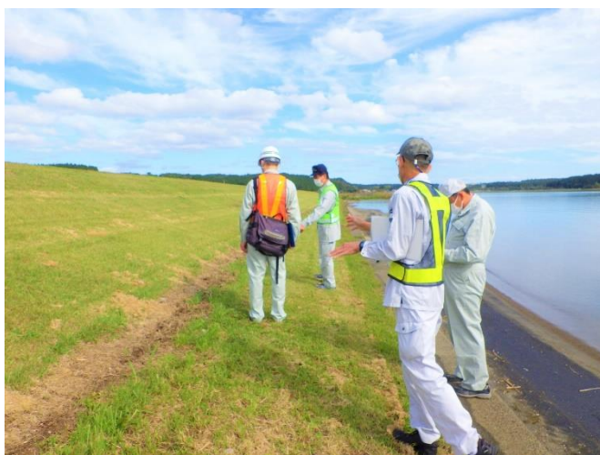
堤防の点検状況
