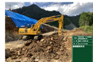
擁壁基礎の床堀(丁張りなし)
