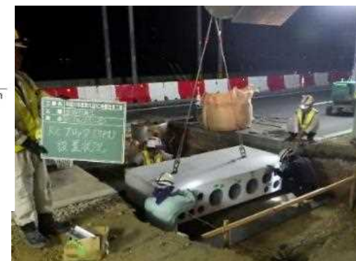
今回取組施工状況写真
