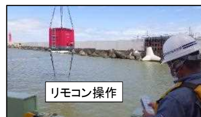
遠隔吊荷制御装置によるブロックの向き調整
