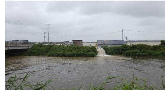
排水ポンプ車による排水作業 8/11 14時
