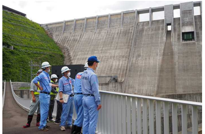
維持工事担当者との点検(白神が故郷橋パーク)
