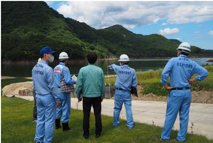
占有者との点検(津軽白神湖パーク)
