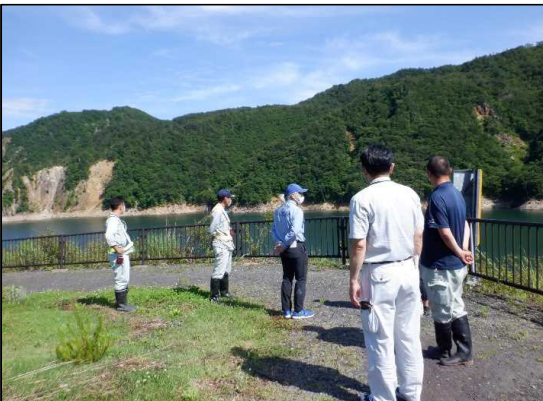
【石淵広場】 異常なし
