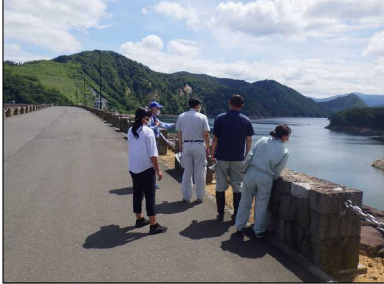
【胆沢ダム堤体天端】 異常なし
