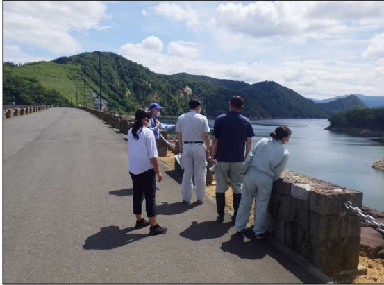
【胆沢ダム堤体天端】 異常なし
