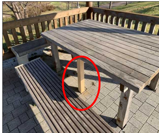
4月15日 修理完了
