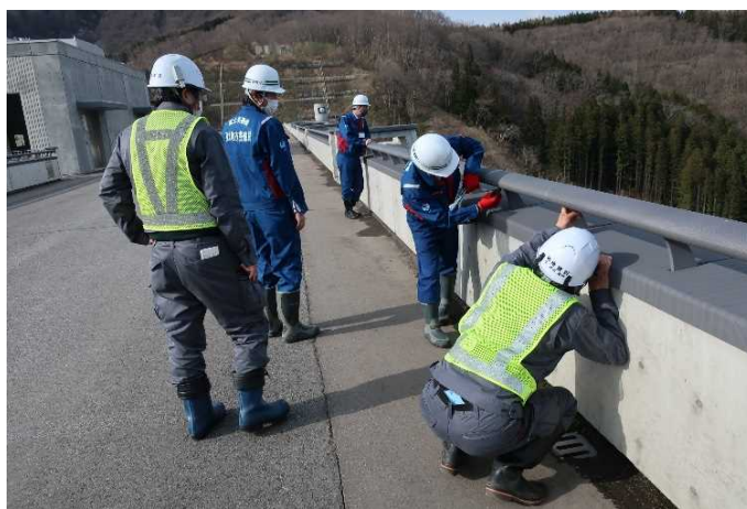
維持工事担当者と点検(津軽ダム堤体天端)
