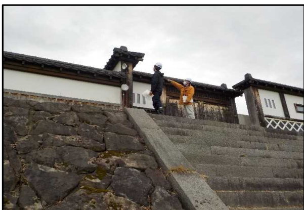
大石田出張所管内 親水公園での点検状況
