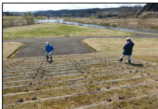
鮭川出張所管内 水辺の学校での点検状況
