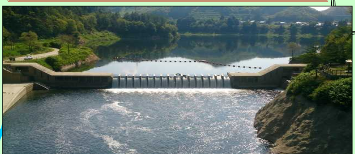
錦秋湖大滝（貯砂ダム）全景（水のカーテン）
