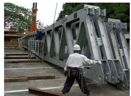
写真－④ 組立状況
